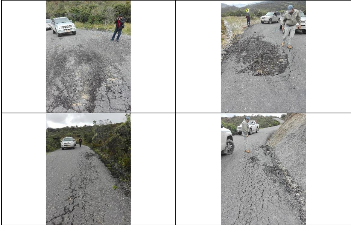
Tramo que presenta: fisuras longitudinales, fisuras en bloque, fisuras de Borde, fisuras por deslizamiento, hundimiento, desintegración de la carpeta del pavimento.
